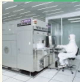
八王子工場内クラス10クリーンルーム(写真の装置はウェーハ外観検査装置「WIN-WIN 50」)
