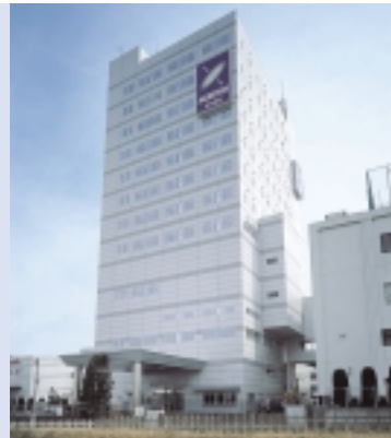
今春竣工したクリーンルーム完備の八王子工場新本館
