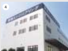
株式会社エスケー・マイクロテクノロジー 株東精エンジニアリング 本社・工場
