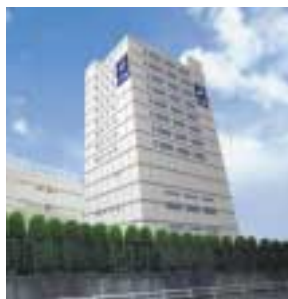
新本館完成予定図 東京精密は、八王子工場内に新本館を建設中です。新本館は、生産フロアやオフィス、ショールームなどに利用する目的で、2000年5月初旬に着工し、2001年3月末竣工を予定しています。
